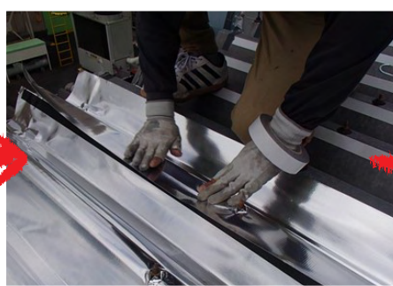
シートの繋ぎ処理
