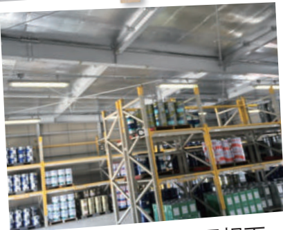
危険物貯蔵所の屋根下 (揮発性塗料保管庫)
