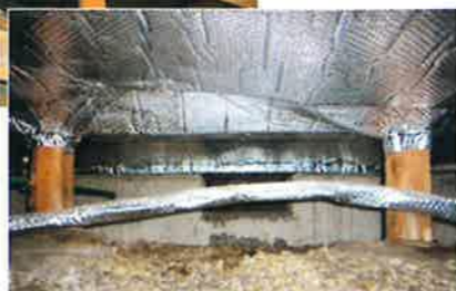
施工後の床下
