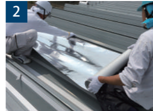
2 サーマーバリアスカイシートを両面テープに接着させます。
