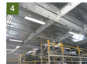
4 シートのジョイントを専用アルミテープで繋ぎ止めて完成です。
