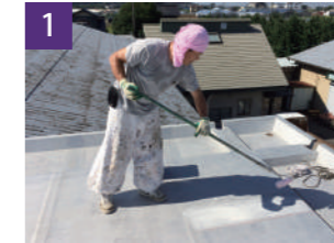
1 接着面を洗浄し、シート幅に専用接着剤を塗布します。
