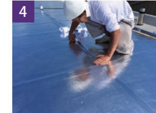
4 シートのジョイントと端部を専用アルミテープで貼り合わせます。
