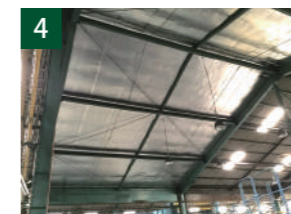
4 シートのジョイントを専用アルミテープで繋ぎ止めて完成です。
