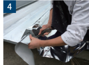
4 先端部分からはみ出したシートを折板屋根に合わせてカットし完成です。
