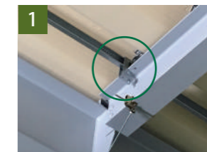
1 折板屋根の下にサーモバリアを張る下地となる軽量鉄骨材を取付けます。
