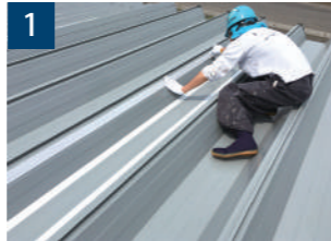
1 折板屋根を洗浄し両面テープを取付けます。
