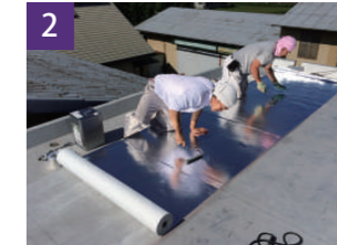
2 接着剤の上からサーモバリア・トップを転がし貼付けます。
