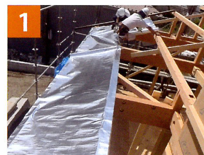
母屋の上にサーモバリアエアを取付
