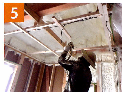
母屋の上にサーモバリアエアを敷き、タルキを取付け通気層を確保し、 発泡ウレタンをサーモバリアエアに吹付けます。
