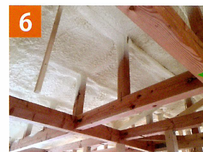
母屋の上にサーモバリアエアを敷き、タルキを取付け通気層を確保し、 発泡ウレタンをサーモバリアエアに吹付けます。
