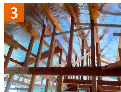
屋根の下から見た状態
